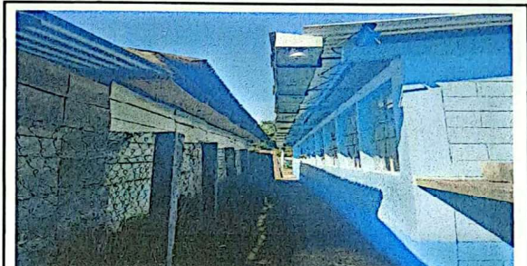
Foto 4: Canales y pintura de la parte de atrás de la escuela finalizado.
