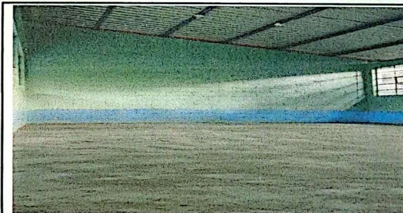
Foto 5: Fundición de piso finalizado en las aulas.
