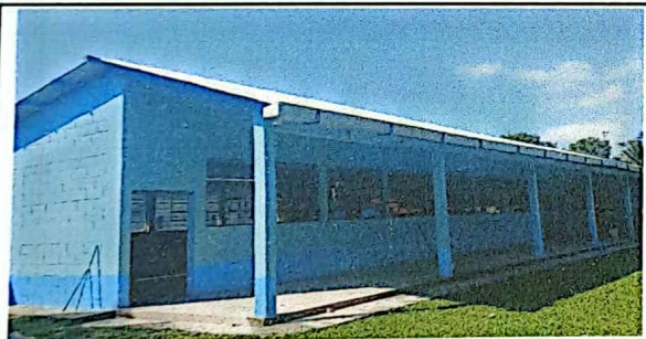
Foto 4: Cambio canales y bajadas de agua pluvial finalizado.
