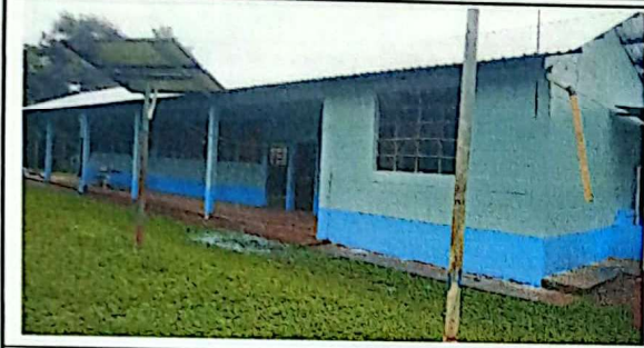
Foto 1: Finalizado el cambio de cubierta de lamina de la escuela.
