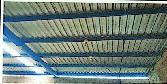
Foto 3: Pintura de costaneras finalizado.
